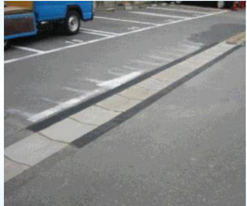
2. 補修箇所にアスファルトピッチを投入。
