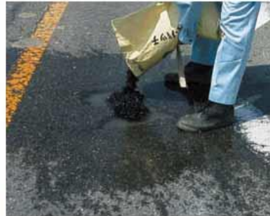
2. 補修箇所にアスファルトピッチを投入。
