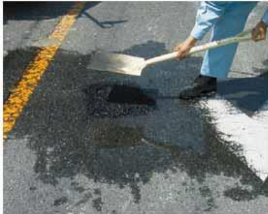
3. アスファルトピッチをスコップで平らに。
