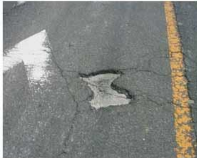
1. 陥没や痛んだ路盤のゴミを取り除く。
